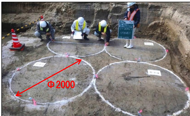
◀ 杭頭確認状況
